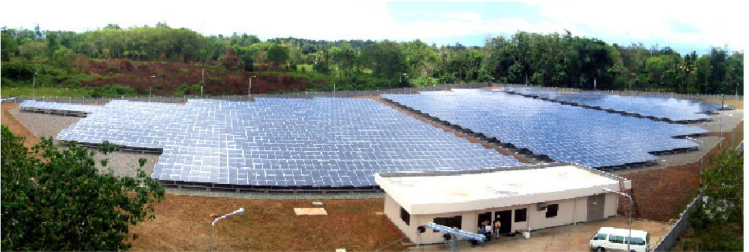
*Injection d'1MW photovoltaïque dans un réseau isolé aux Philippines*
