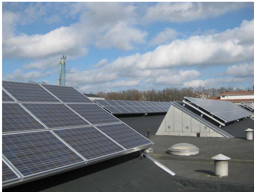
Figure 1: Ett exempel på ett nätanslutet takmonterat solcellssystem på Kungsmadskolan i Växjö (Foto: Mats Andersson)
