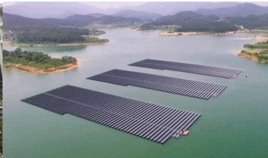
<Jipyong Reservoir On-water PV, 6 MW>
