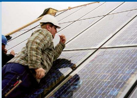
Installation of two roof integrated PV-systems in Hammarby Sjöstad, Stockholm (JM Byggnads AB). Total installed capacity 11,4 kWp semi transparent modules. (photo - Jonas Hedström, Energibanken, 2001)
