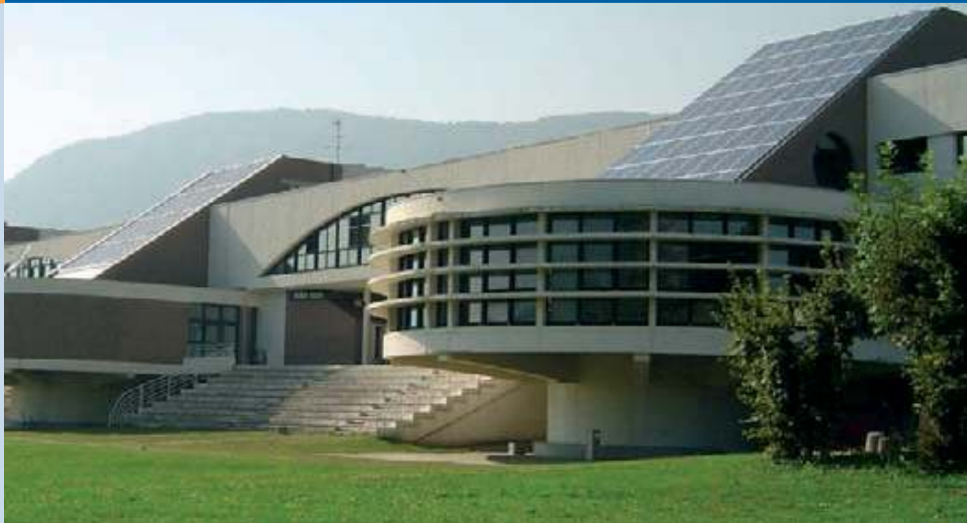
Fig. 3 - UNIVERSOL project, Lycée du Grésivaudan, Meylan (Isère): 45 kW BIPV (photo courtesy of Pienergies/Hespul).
