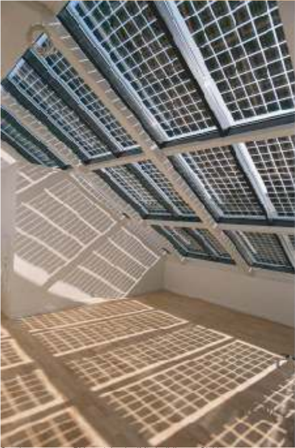
Semi-transparent PV modules in JM's building at Sickla udde, Hammarby Sjöstad. Photo by Lars Hansson
