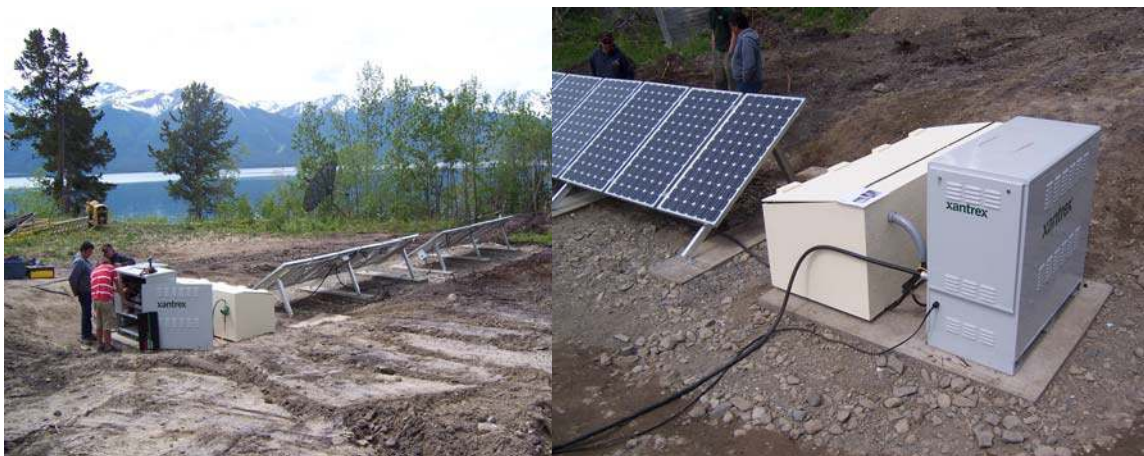
Figure 3 : Le système d'alimentation hybride de Xantrex permet de diminuer la consommation de combustible classique des génératrices par les Premières nations et accroît la fiabilité des systèmes dans les régions éloignées (Photo : Xantrex)
