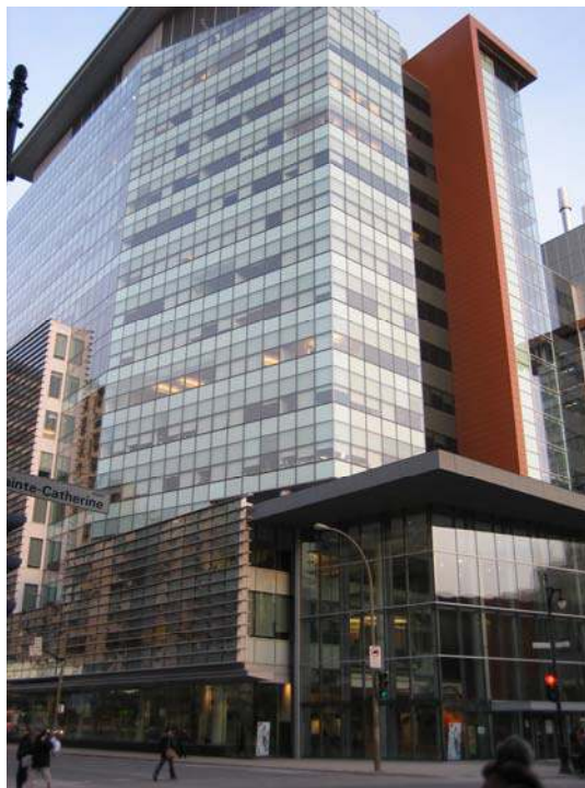
Figure 4: Siège social du Réseau de recherche sur les bâtiments solaire, Université Concordia, Montréal (Canada)
