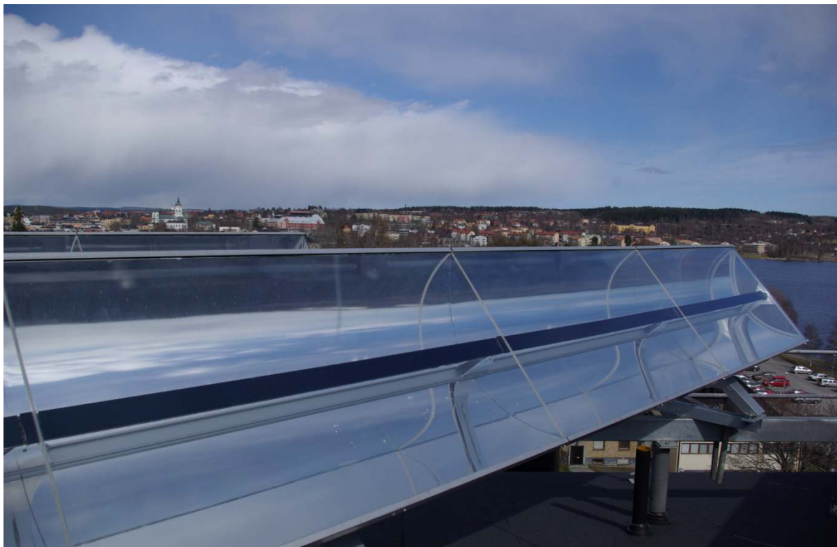
Figur 3: På taket till sjukhuset i Härnösand finns ett hybridsystem som levererar både el och värme. (foto: Joakim Byström, Absolicon)
