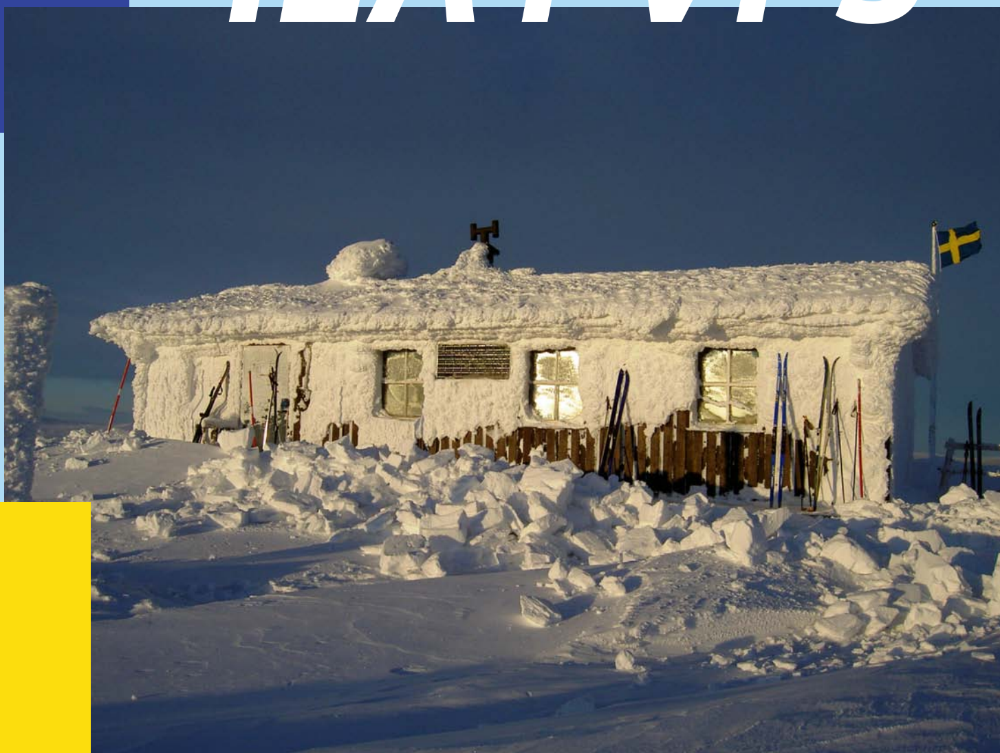
Ett fristående system på Dundret, Gällivare, med en modul från Eco Supplies AB. Foto: Eco Supplies AB
