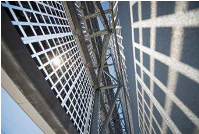
그림 4: SWCT™에 의해 상호연결된 양면형 SHJ 셀로 구성된 스위스 Neuchâtel의 개조된 CSEM 건물의 SWCT-CSEM 파사드-반투명 파사드.
