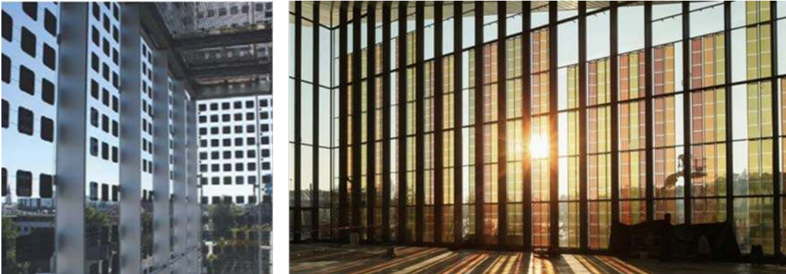
그림 9. 단결정실리콘(c-Si) 태양전지로 만든 반투명(semi-transparent) 창 (왼쪽, source: Ertex Solar) 과 염료감응 태양전지로 만든 컬러 투명 창 (오른쪽, source: Alain Herzog, Architect: Richter Dahl Rocher)
