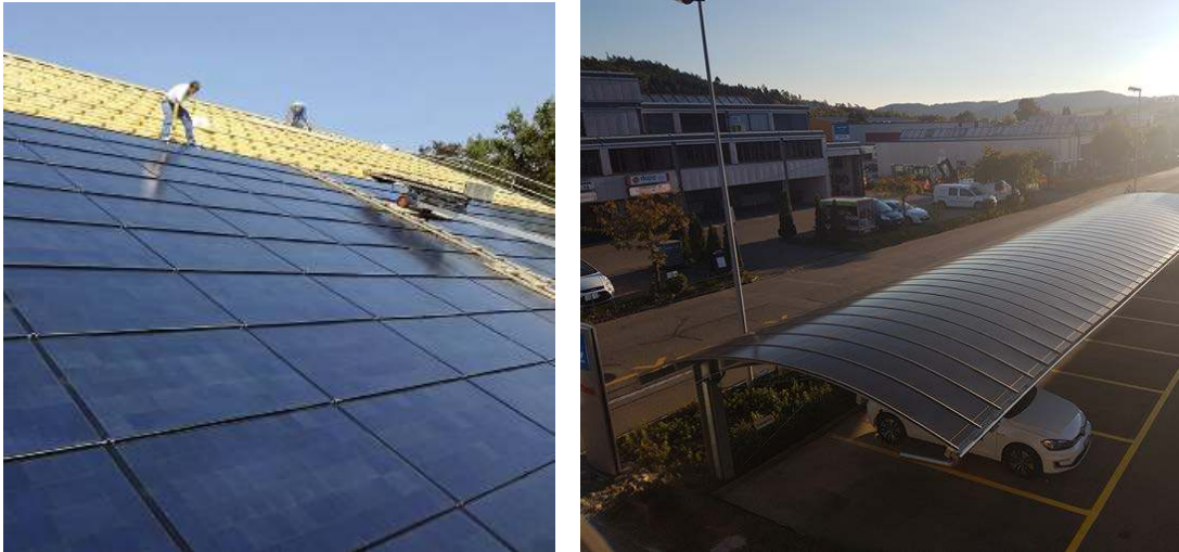
그림 10. 정규 모듈을 사용한 평탄형 불연속의 뺏뺏한 지붕 (왼쪽, source: Schweizer) 과 대형 플렉시블 모듈을 사용한 곡선형 주차장 지붕 (오른쪽, source: Flisom)
