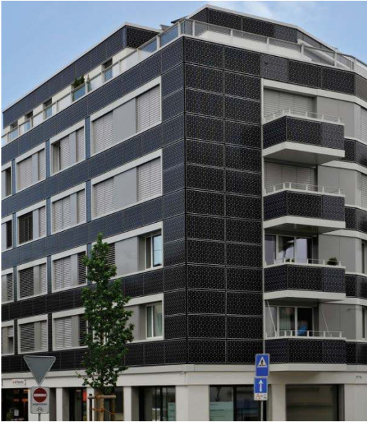
그림 11. 스위스 Romanshorn의 Alleestrass에 있는 다가구 주택용 건물에 표준형 태양광 건축 언어의 사용 (왼쪽, source: Viridén + Partner) 과 독일 Stuttgart에 있는 Z3 시범 건물에 사용된 맞춤형 태양광 glazing에서의 위장된 외관 (오른쪽, source: Ed. Züblin AG)
